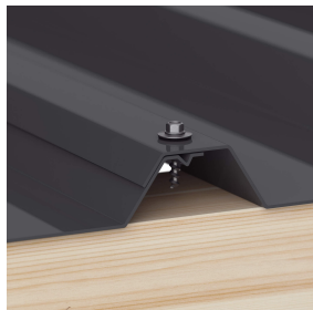
Überlappungen werden immer auf der Hochsicke befestigt (ca. 3 p/m 2 )
